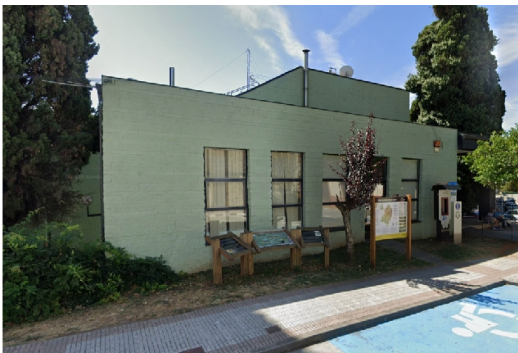
Fachada principal Casa de Cultura
